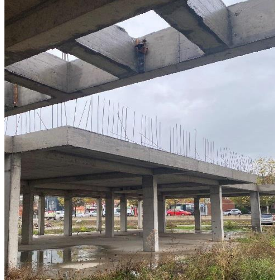
Fotografia 5. Objekt i demoluar
